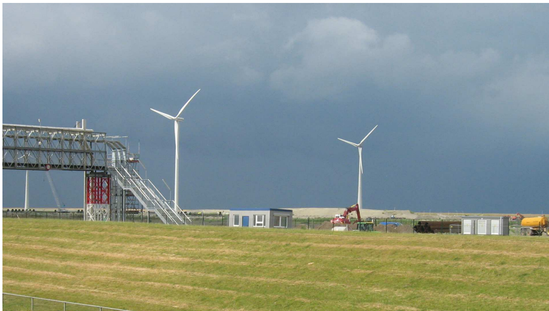
Turbines nabij de centrale van GDF SUEZ Nederland in het oosten de Eemshaven (bovenste foto) en aan de Schildweg nabij Bakker Bierum aan de zuidzijde van de Eemshaven (onderste foto) (foto's A&W).
